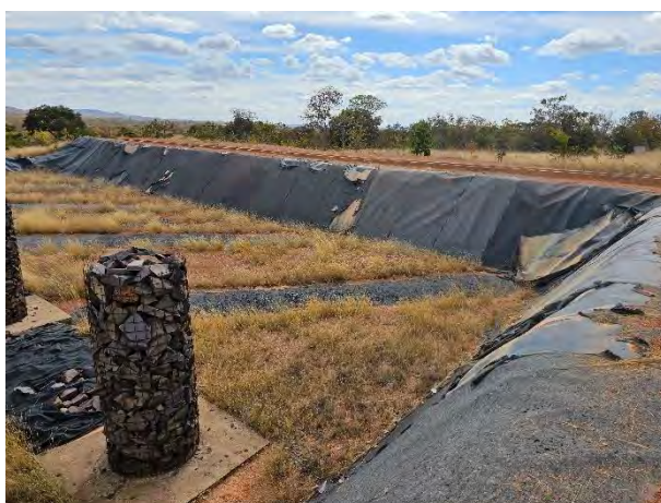
Figura 19 - Drenagem de Biogás e de líquidos lixiviados
