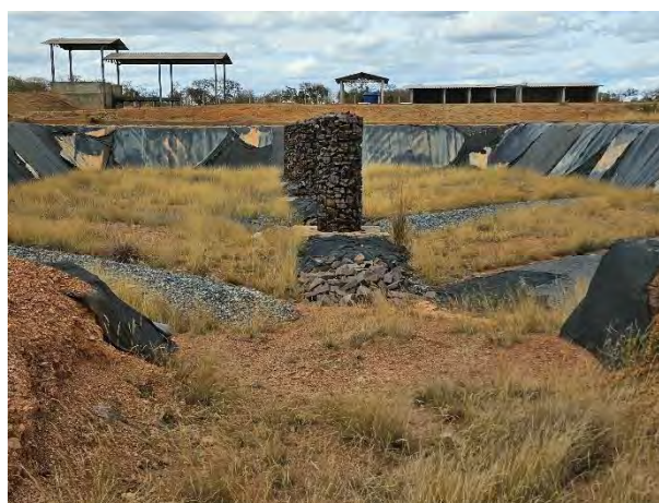
Figura 19 - Drenagem de Biogás e de líquidos lixiviados
