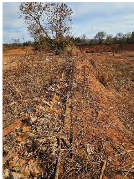
Figura 10 - Sistema de drenagem pluvial (canaletas) danificado
