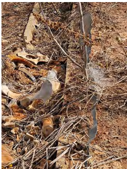
Figura 10 - Sistema de drenagem pluvial (canaletas) danificado
