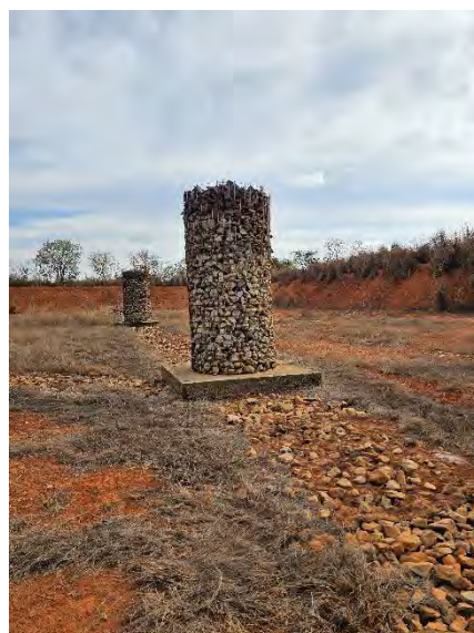
Figura 7 - Sistema de drenagem de biogás que foi implantado
