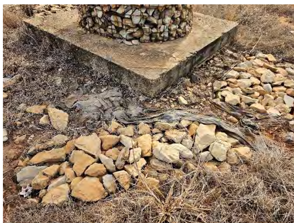
Figura 8 - “Ponta da geomembrana de PEAD que foi vandalizada
