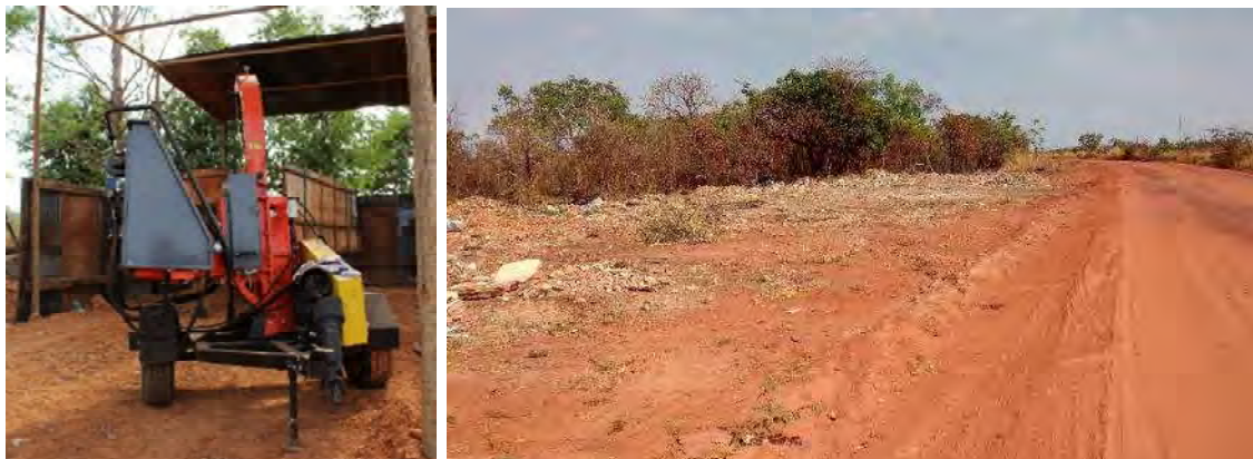
Foto 34 - Equipamento de pequeno porte para picotamento de madeira em Arinos e aproveitamento do RCC em valas de vicinais de Formoso
