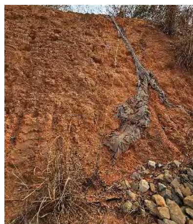
Figura 8 - “Ponta da geomembrana de PEAD que foi vandalizada
