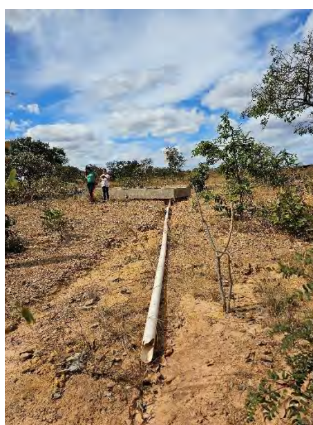
Figura 24 - Lançamento de lixiviados sobre o solo
