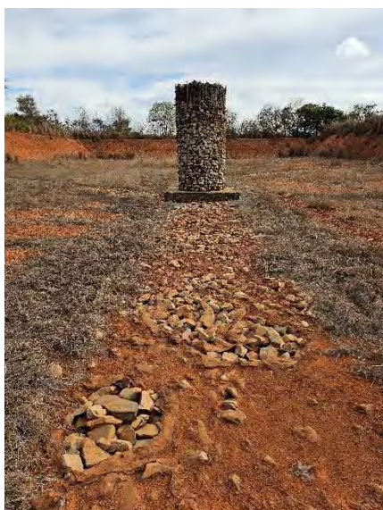
Figura 7 - Sistema de drenagem de biogás que foi implantado
